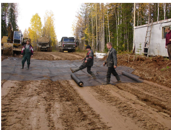
Рис. 5. Укладка геосетки под дорожное покрытие
