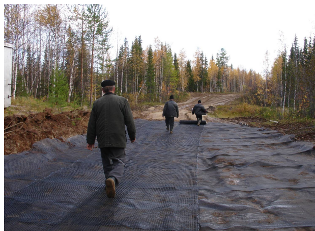
Рис. 5. Укладка геосетки под дорожное покрытие
