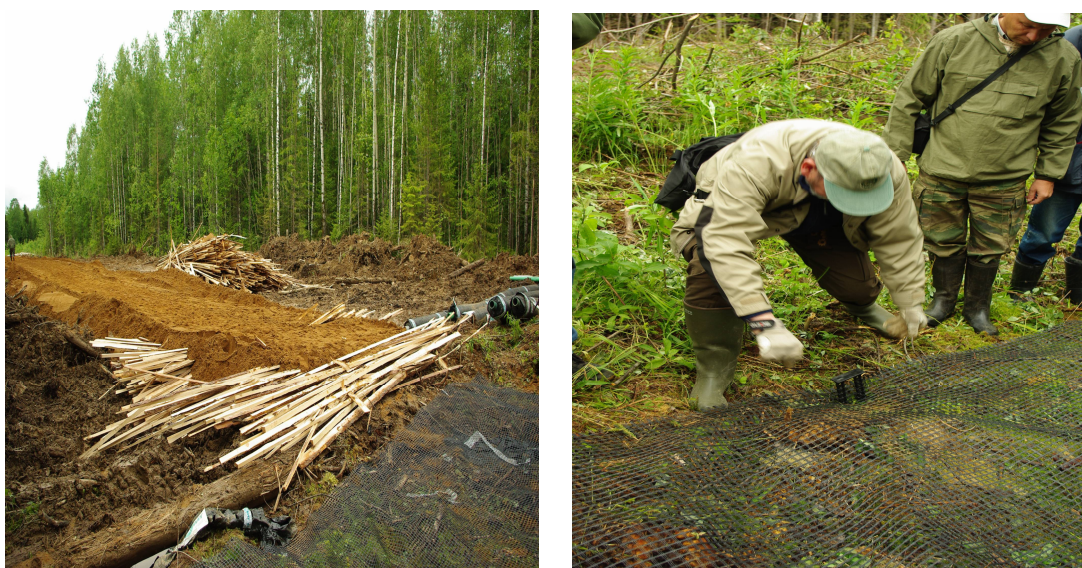
Рис. 6. Укладка геосетки с использованием древесных отходов в качестве дорожного покрытия
