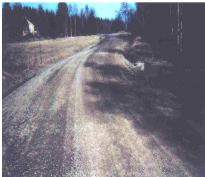
Рис. 4. Состояние дороги через 5 лет после ремонта с использованием летучей золы
